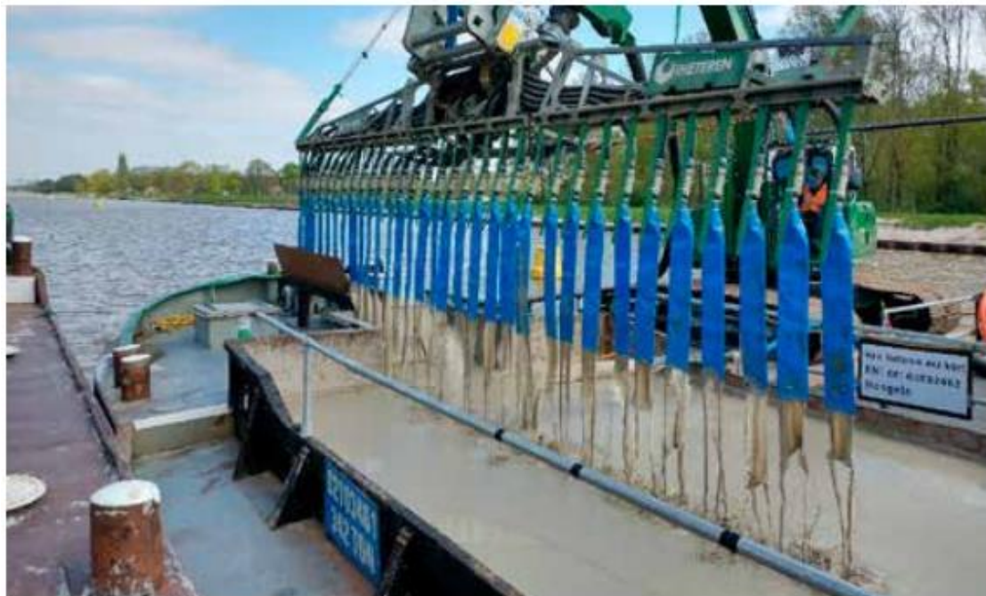
Een door de aannemer ontworpen sproei-installatie waarmee het ZBM vanuit een beun in banen op dichtbij de kanaalbodem wordt aangebracht.
