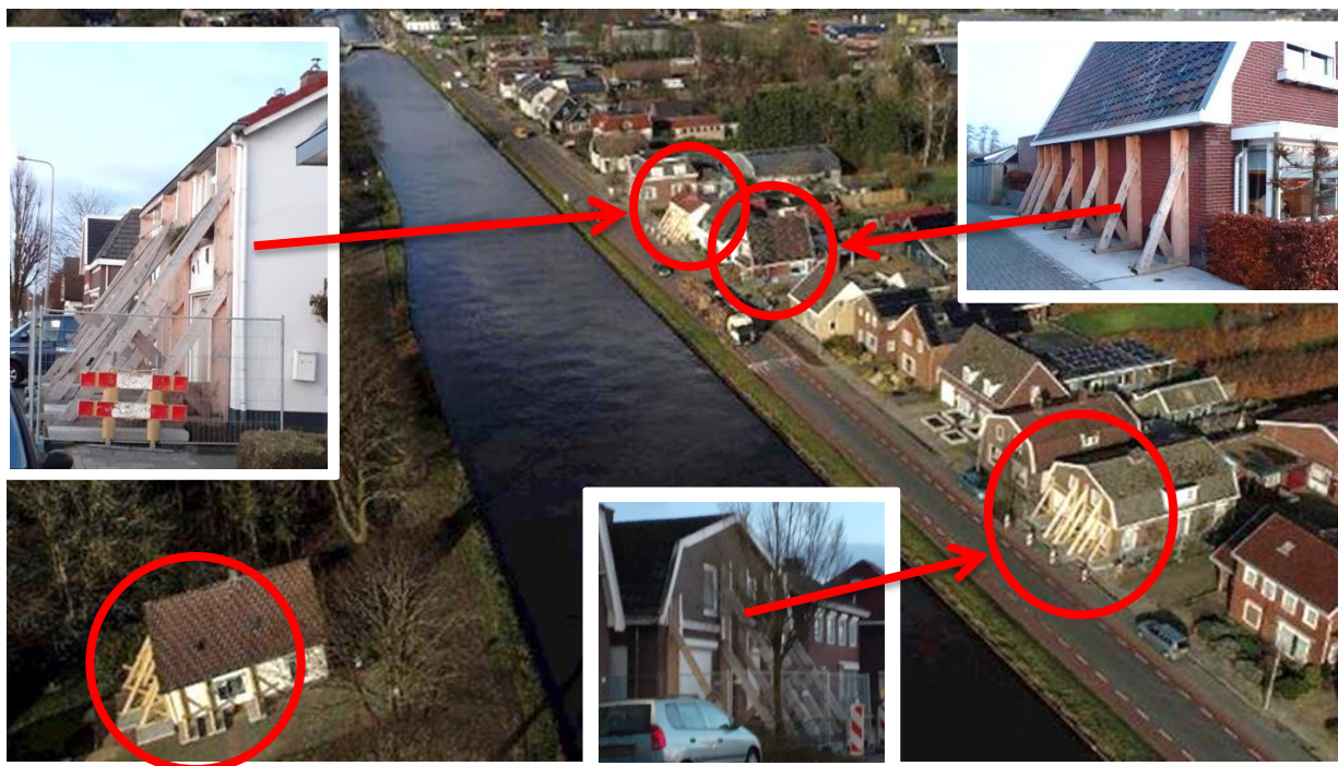
De verzakte en gestutte huizen aan de Vriezenveenseweg en de Vierzonenweg in Vroomshoop.
